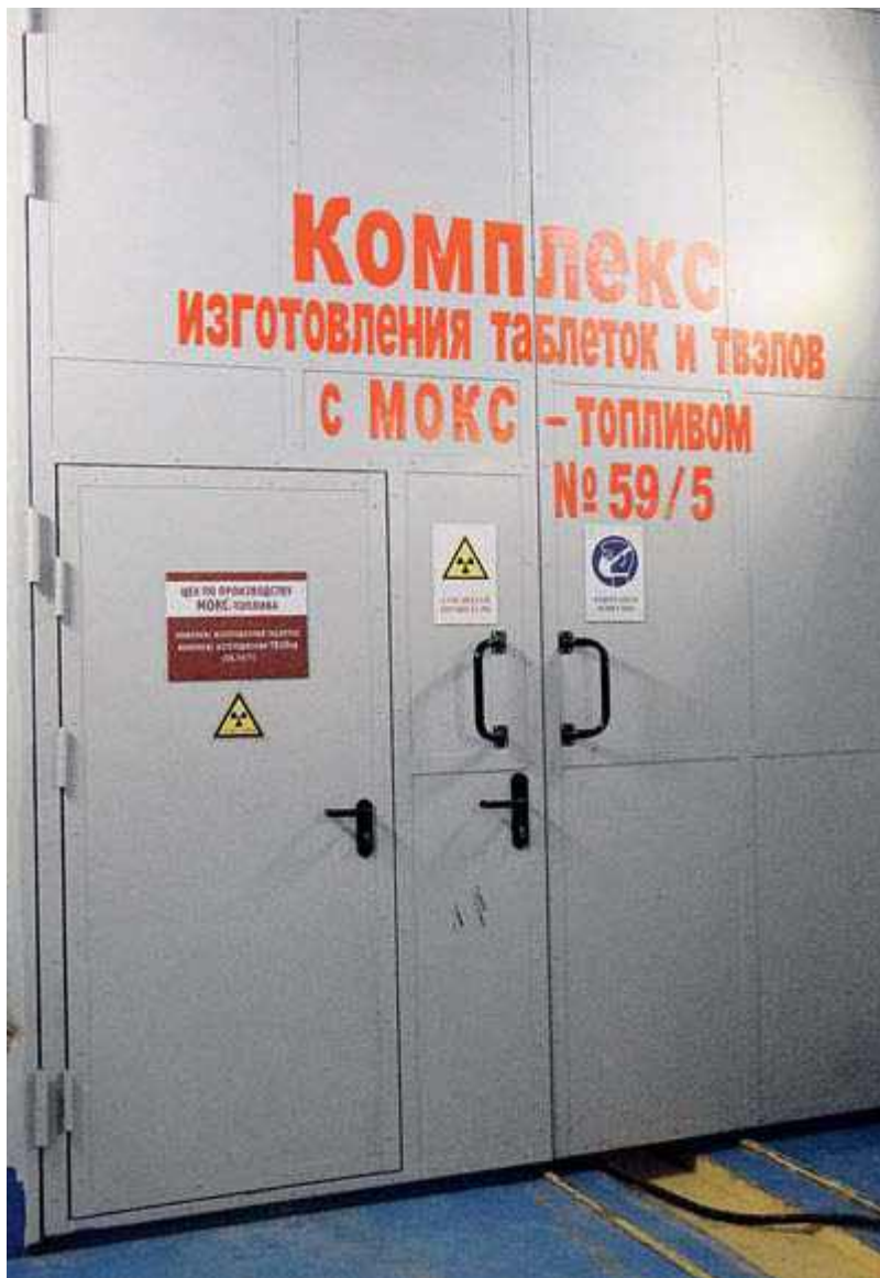
Рисунок 2.3.1 – Вход в Комплекс изготовления таблеток и твэлов МОКС-топлива
